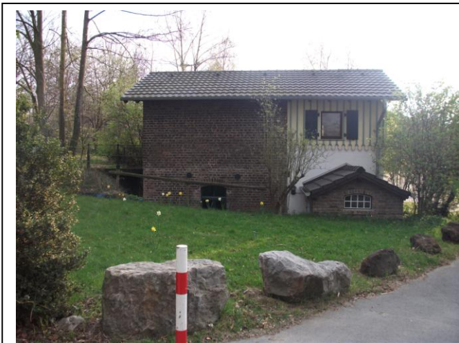
Die alte Brikettwaage heute: Dort wo der weiß verputzte Anbau steht, verlief vor 100 Jahren ein Gleis, auf dem die Loren gewogen wurden. In der linken Hälfte des Gebäudes waren Briketts aufgeschüttet, die zum Austarieren der Loren genutzt wurden.
